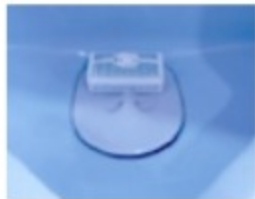
既存目皿設置
